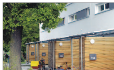
Energiesparhäuser - Reihenhäuser im KfW 60 - Programm
